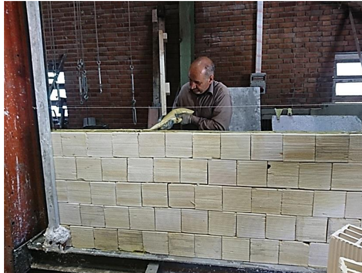
شکل ۳- ساخت دیوار سفالی برای خمش دیوار سه متری
