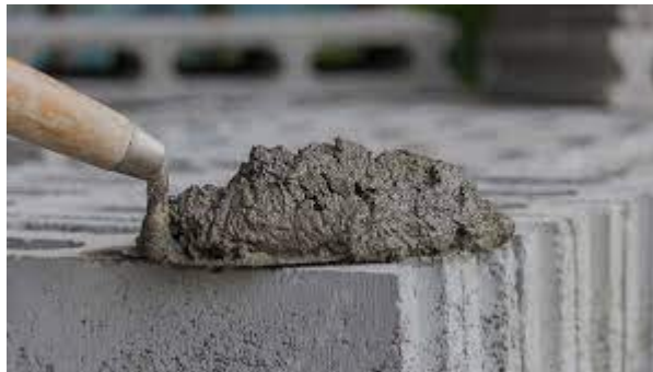
شکل: اجرای ملات سبز خمیری بدون نیاز به آب
